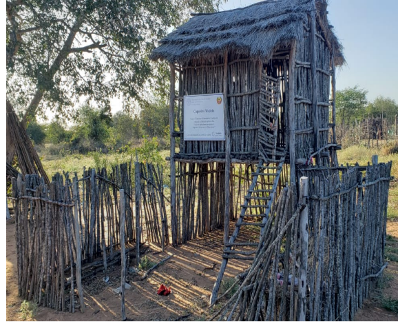
Figura 9: Reservatório de água da chuva
